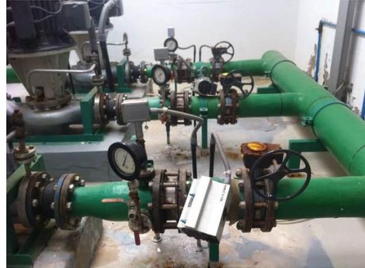
*Detalle de las válvulas y manómetros a sustituir en la captación de agua de mar*
